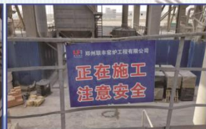
185T/D石灰窑施工现场
