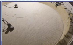
54000KVA电石炉内衬砌筑
