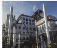
新疆天业40500KVA密闭电石炉厂房排烟除尘系统
