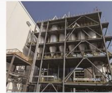
中盐吉兰泰48000KVA密闭电石炉炉气净化回收系统
