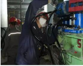
**资深液压工孙晓东：**孙晓东负责电石厂液压系统日常检维修。早上 9:30 到工作岗位，他就提前准备工具材料，然后迅速投入到检修工作中。4 号炉电石炉运行已有 10 年之久，液压系统备件都出现了老化现象，日常故障明显增多，这一问题深深地影响着电石炉运转，此次 4 号电石炉大修，他很用心的利用大修的机会，彻底解决液压系统老化故障的问题。控制电极压放的电磁阀就是比较精密的备件，在运行了 10 年之后，已经出现磨损、内漏现象。孙晓东对 4 号电石炉的夹钳缸压放缸电磁阀进行了集体更换，以确保送电后电石炉液压系统的稳定运行。
